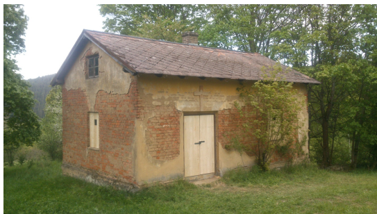
Celkový pohled s novými dveřmi
