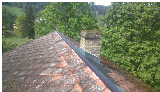
Opravený hřeben střechy
